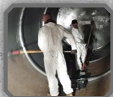
ZABEZPIECZENIE ANTYKOROZYJNE BETONU I STALI
